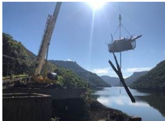
Limpeza da tomada de água da UHE Castro Alves – maio de 2021
