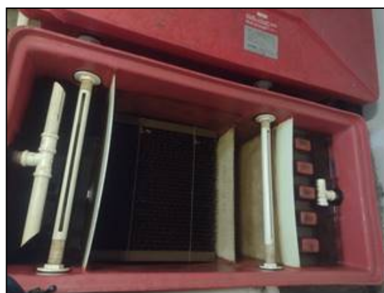
Limpeza das caixas separadoras de água/óleo na UHE 14 de Julho – Novembro de 2021
