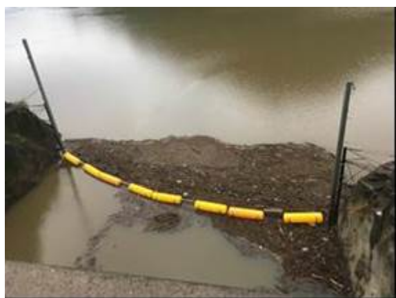
Vista do log boom da tomada de água da UHE Castro Alves antes e depois da limpeza - junho
