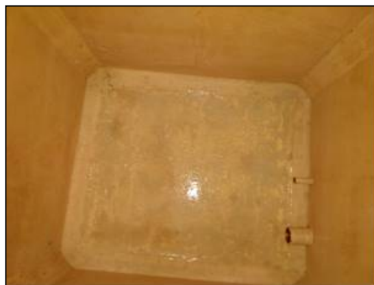
Desinfecção realizada com uso de hipoclorito de sódio após a limpeza – UHQJ – julho 2021
