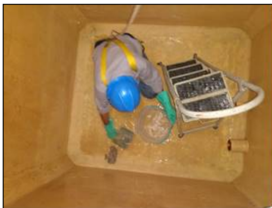
Desinfecção realizada com uso de hipoclorito de sódio após a limpeza – UHQJ – julho 2021
