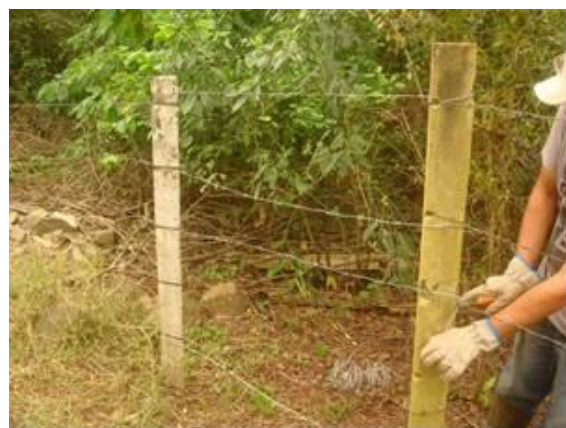
Gleba E-040: cerca danificada e fechamento de passador.
