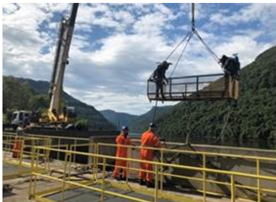
Limpeza da tomada de água da UHE Castro Alves – maio de 2021
